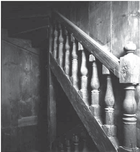
Escalier tournant à balustres en bois
