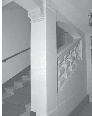
Escalier rampe sur rampe sans jour, balustres en pierre
