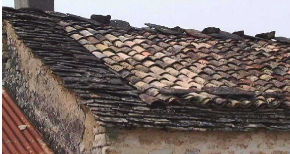
vestiges d'une couverture en lauzes
