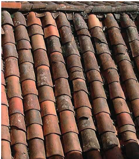
tuiles creuses = couverture traditionnelle
