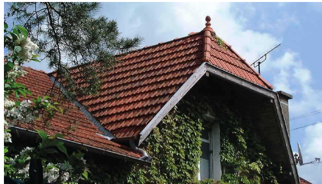
tuiles mécaniques = 1875-1950
