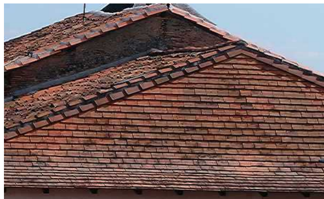
tuiles plates = couverture traditionnelle en bordure est de la Vienne et de la Charente
